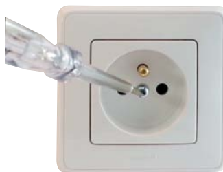
Krok 7. Przykręcenie śruby mocującej
